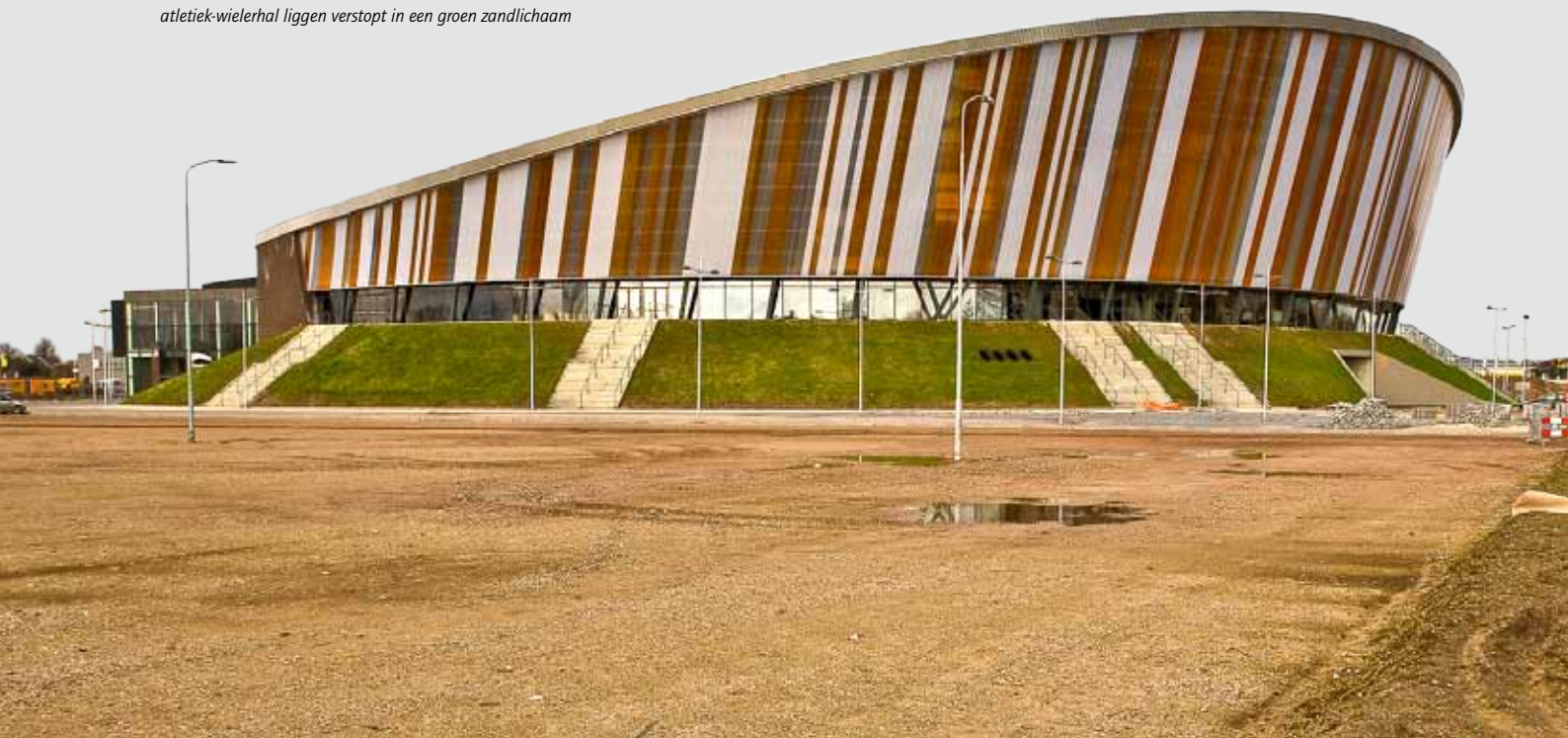
Exterieur van Omnisportcentrum, tribunens van de gecombineerde atletiek-wieleral liggen verstopt in een groen zandlichaam
